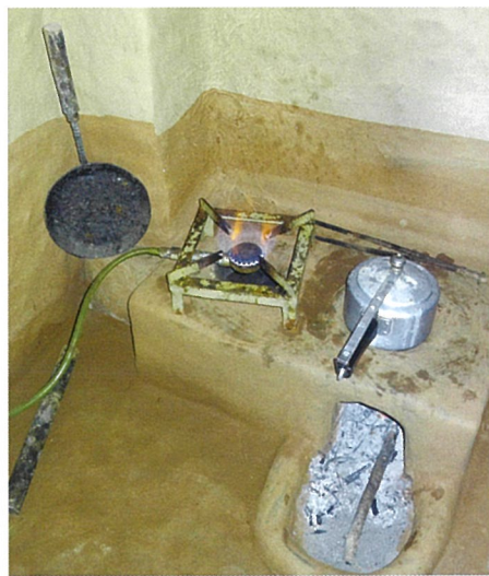
設置したバイオガストイレ（左）と、そこから発生したメタンガスを使って、調理用のコンロに点火
