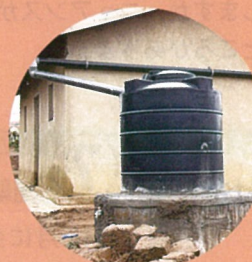
製作研修を経て、集水タンクを設置
