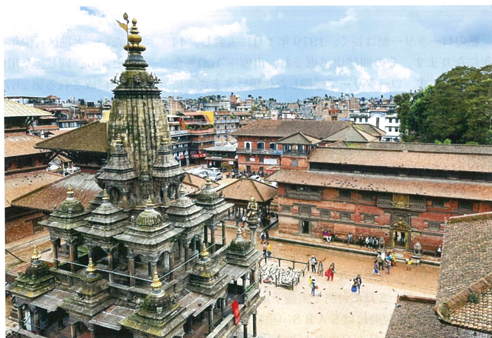
木材やくぎは一切使わず、石造りで建てられたクリシュナ寺院（左手前）
