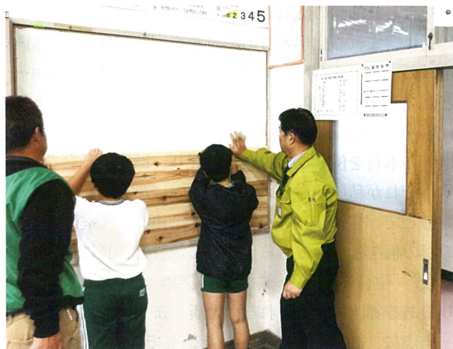
指導を受けながら、杉の板を丁寧に張り付け
