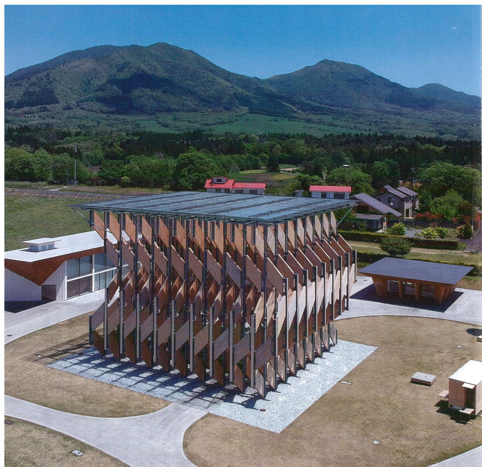
岡山県真庭市の観光文化発信拠点施設 GREENable HIRUZEN を象徴する木造建築「風の葉」をメインに 真庭市提供
