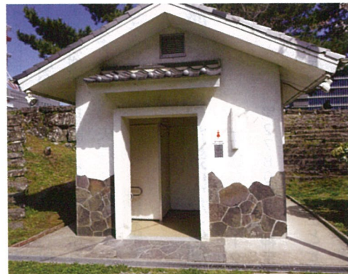
より使いやすく改修した公衆トイレが完成
