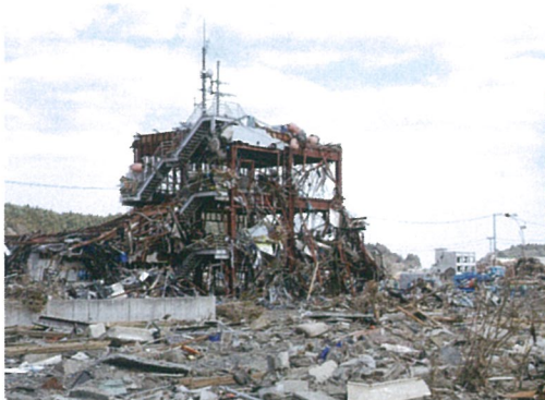
（左）被災した防災対策庁舎
