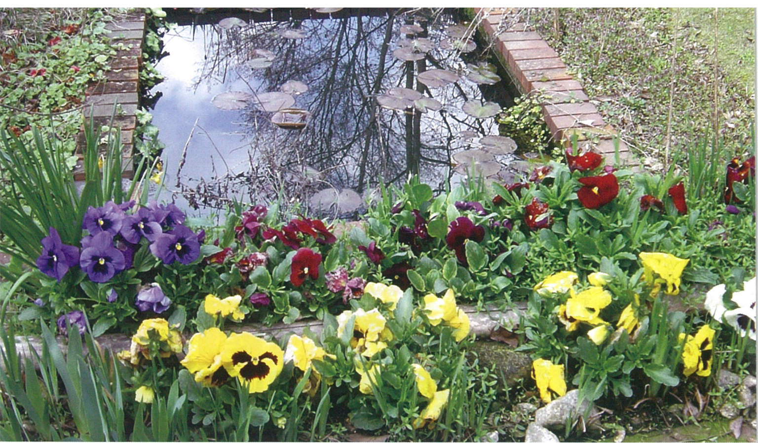
まさにビオトープ。これが污水处理槽？ 一見、花壇風の安藤家の土壌浄化槽の秘密は土の中に。写真提供：安藤忠男
