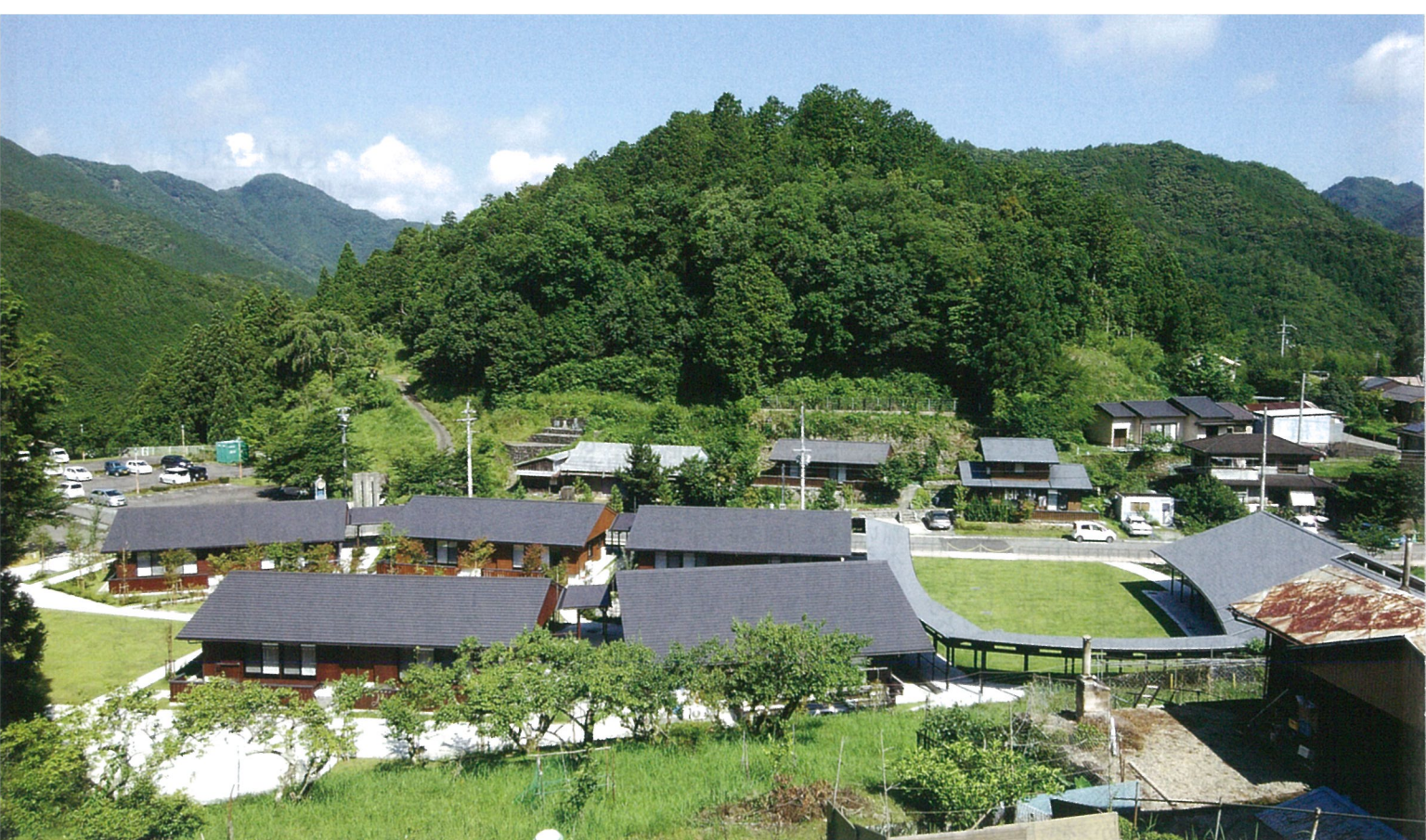
写真提供：十津川村 地元の木材を使って十津川大工が建てた平屋造りの「高森のいえ」。背景の斜面に点在する復興住宅も見える
