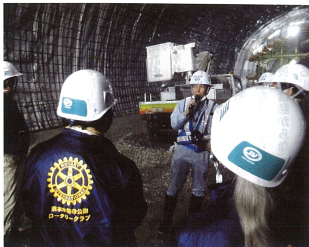
難工事のトンネルを見学する貴重な機会に
