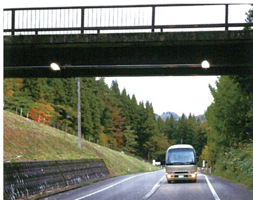
フラワーブリッジに照明灯を設置
