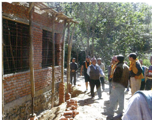
工事中のジャナディーブ高等学校を視察
