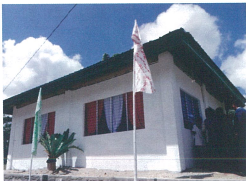
完成した鉄筋コンクリート造りの園舎
