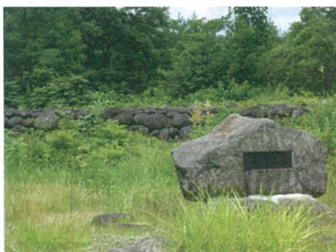
松川の水害防止のため直江兼続がつくった総延長 10km におよぶ直江石堤
