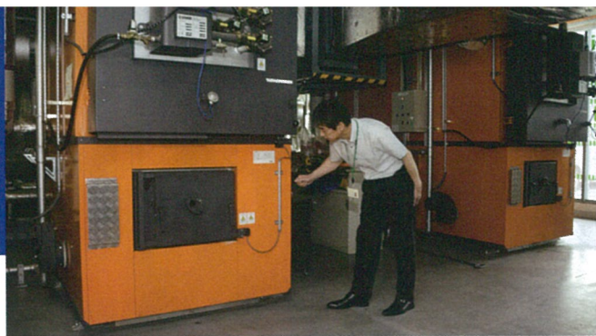
市役所の空調を支えるボイラー（左）と燃料のチップ
